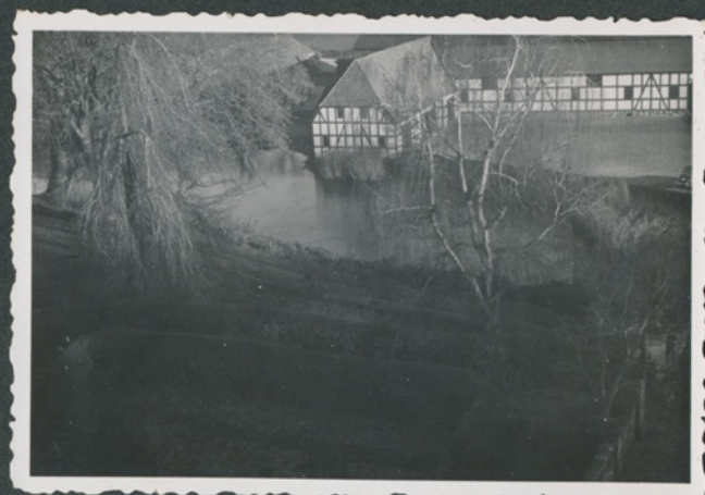
Avlsbygningerne ved Sandholt Slot (Negativfilm 18, nr. 43)
